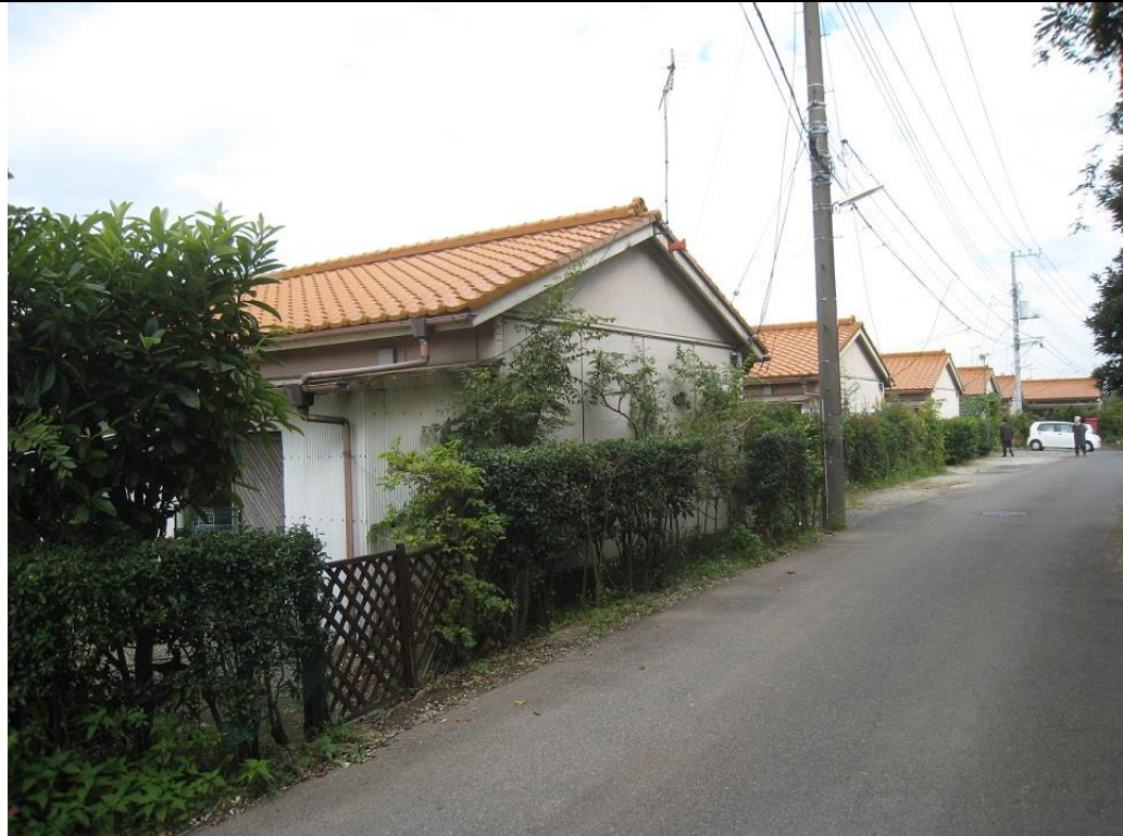
道路側を撮影
