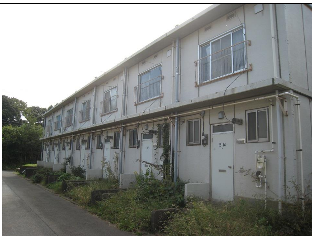
玄関側を撮影
