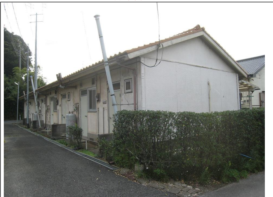
玄関側を撮影
