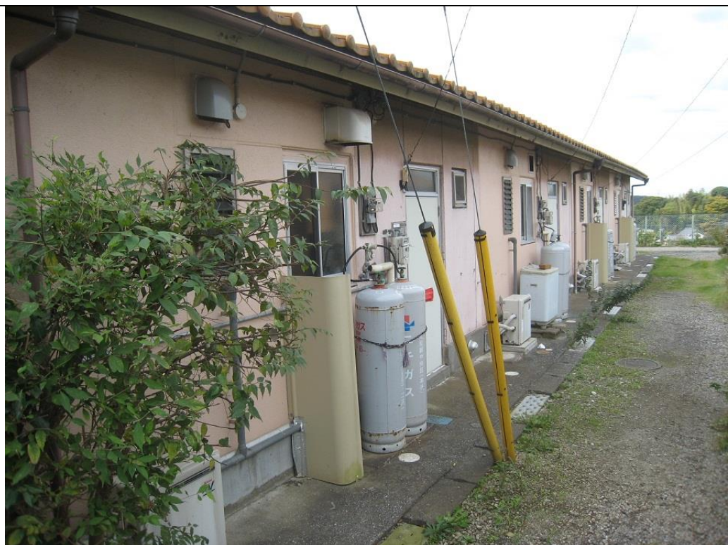
玄関側を撮影
