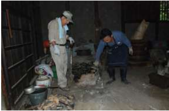
古いカマドの解体作業
