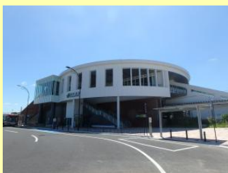
完成した袖ヶ浦駅舎及び自由通路
