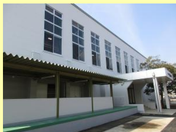
改修後の根形中学校の屋内運動場
