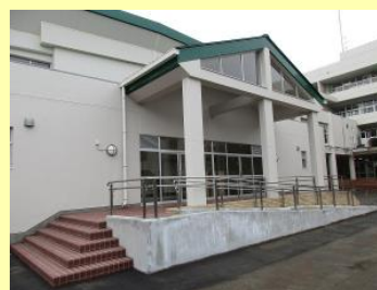
改修後の平岡小学校の屋内運動場
