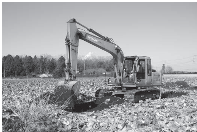
2. 表土除去風景 (南東→)
