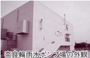
奈良輪雨水ポンプ場の外観
