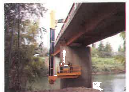
R3 点検時作業状況 (宮川橋)
