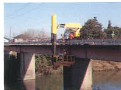
R3 点検時作業状況 (小坪橋)
