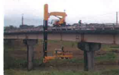
R3 点検時作業状況 (堂谷橋)
