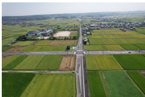
交差点改良工事（市道三箇横田線 Ⅰ期Ⅰ工区）※ドローンで撮影
