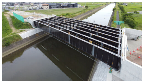
都市計画道路高須箕和田線南袖工区 橋桁架設工事
