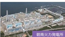
碧南火力発電所
