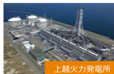
上越火力発電所
