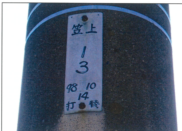
画像資料No. 27 近景 摘要 電柱 作成 令和 8 年 3 月 6 日
