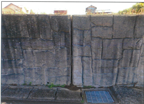
画像資料No. 25 近景 摘要 RC擁壁接続隙間 作成 令和 8 年 3 月 6 日
