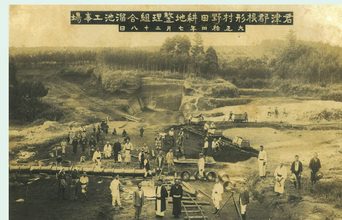
▲野田耕地整理組合溜池工事場の様子(大正14年)
