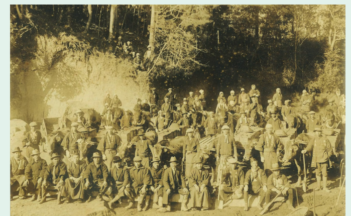
▲農振土木事業三ツ作線工事竣工記念(昭和8年度)
