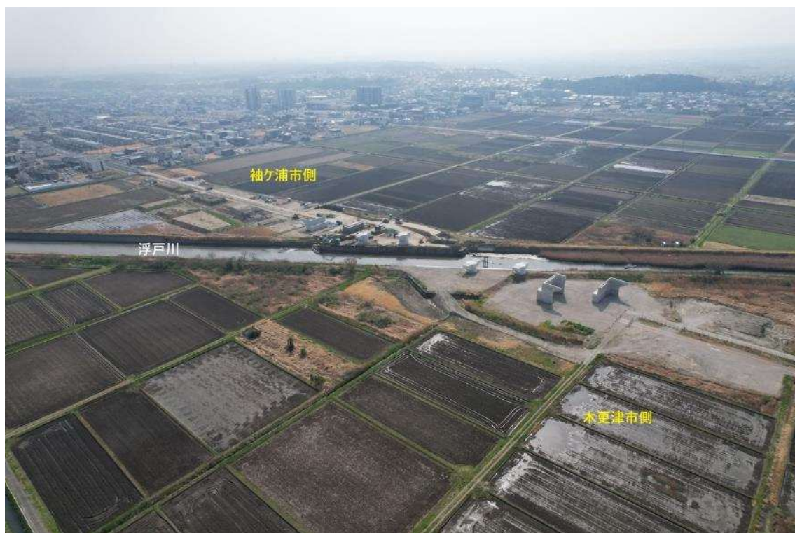
木更津市側から見た工事の様子
