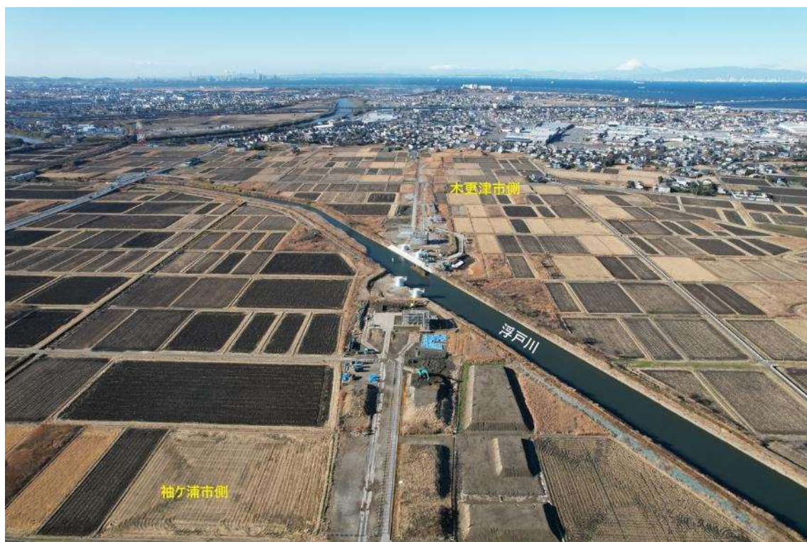
袖ヶ浦市側から見た工事の様子
