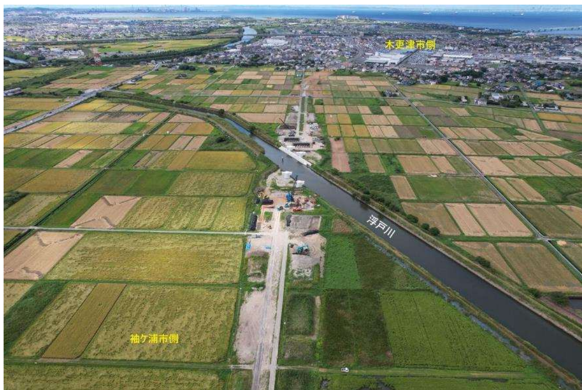
袖ヶ浦市側から見た工事の様子
