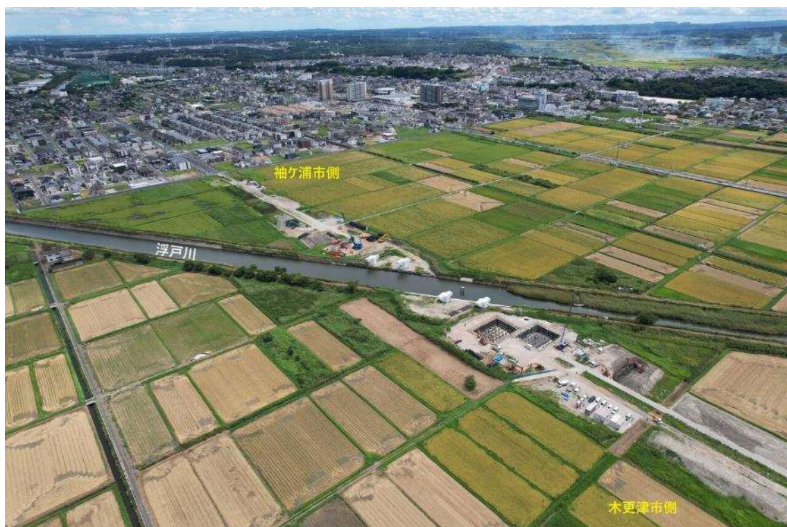
木更津市側から見た工事の様子
