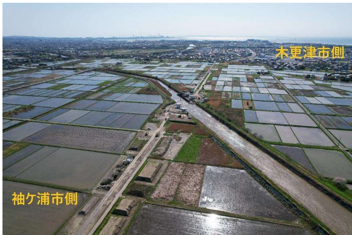
袖ヶ浦市側から見た工事の様子
