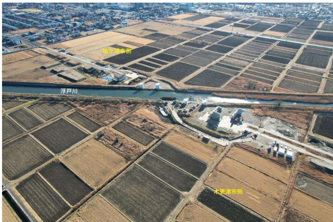
木更津市側から見た工事の様子
