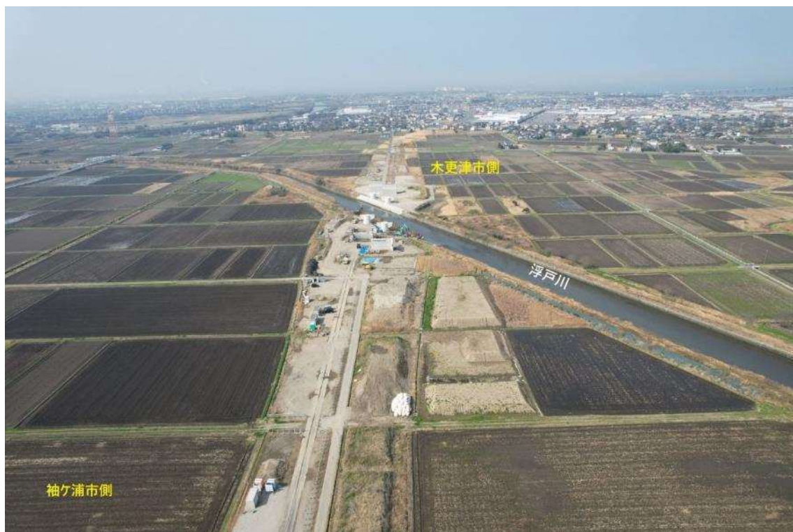
袖ヶ浦市側から見た工事の様子
