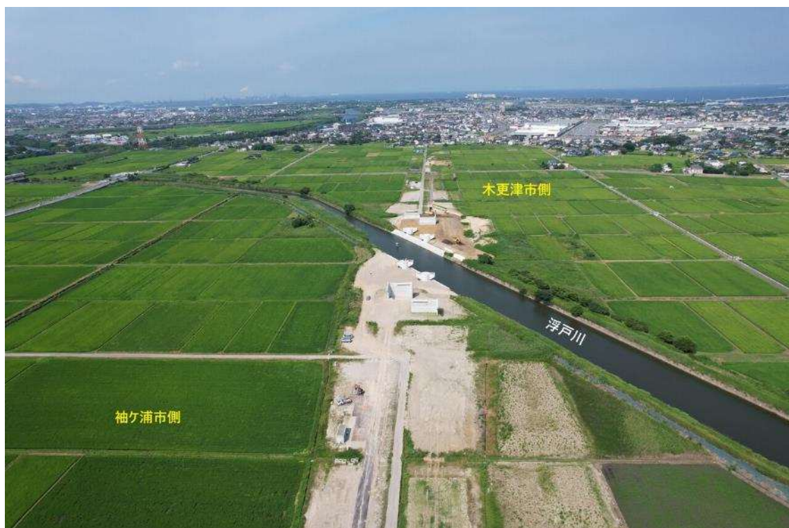
袖ヶ浦市側から見た工事の様子
