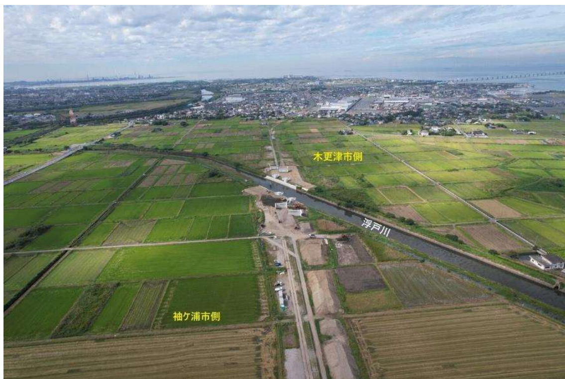
袖ヶ浦市側から見た工事の様子
