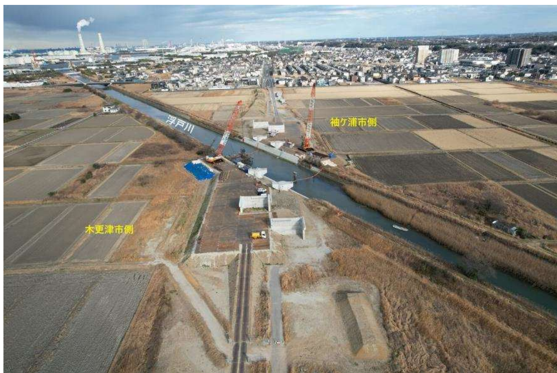
木更津市側から見た工事の様子
