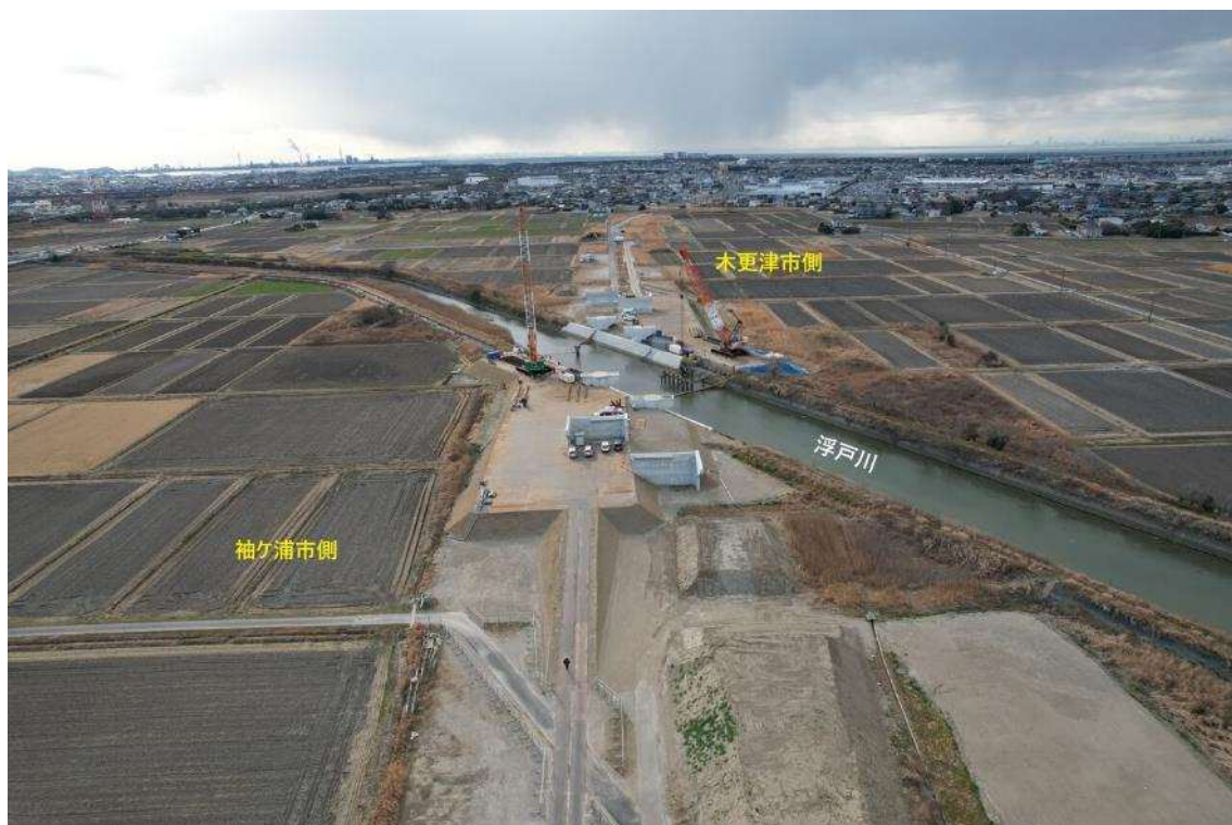
袖ヶ浦市側から見た工事の様子
