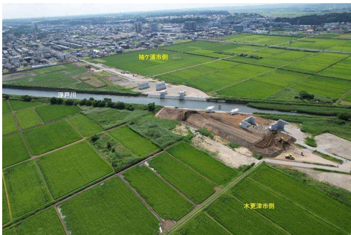
木更津市側から見た工事の様子
