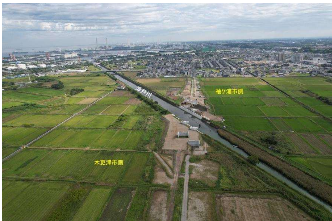
木更津市側から見た工事の様子
