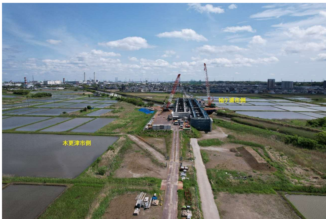
木更津市側から見た工事の様子
