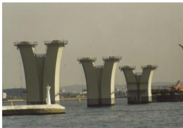
お宝画像！建設中のアクアラインの橋脚です！
