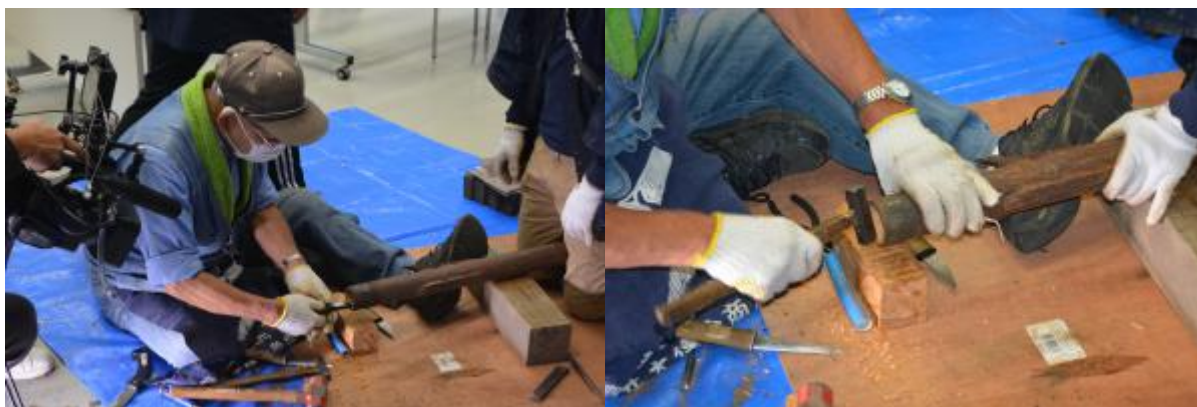
7 コシタの内部端を斜めに削り取る。
