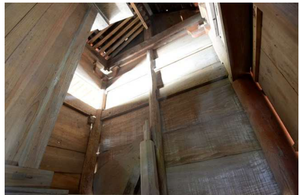
本殿内東壁 立てかけられた部材は大正年間
