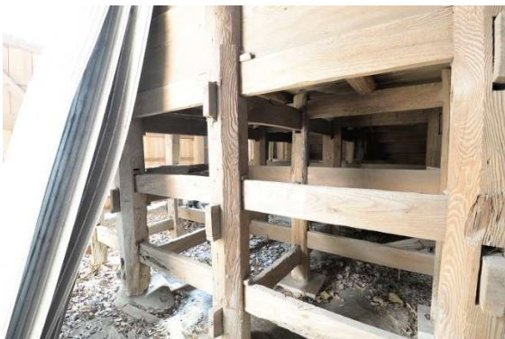
本殿下部の柱（南西から）
