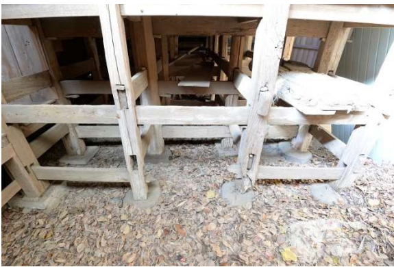
本殿下部の柱（東から）
