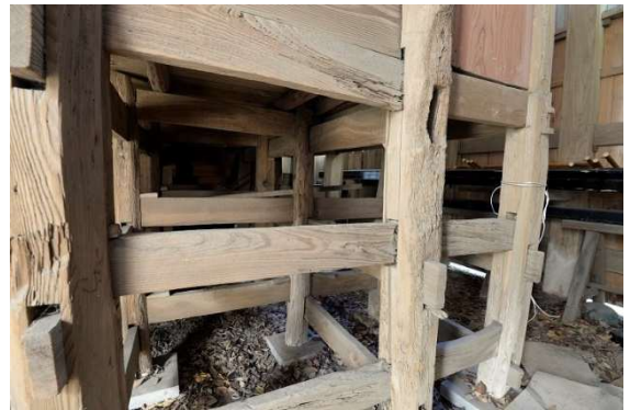
本殿下部の柱（北東から）
