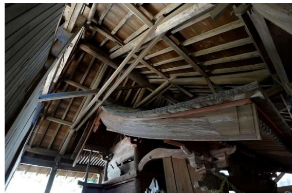
本殿屋根②（南西から）
