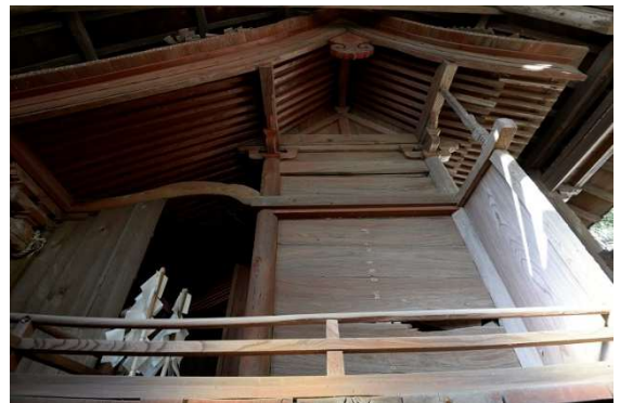
本殿東側面と屋根
