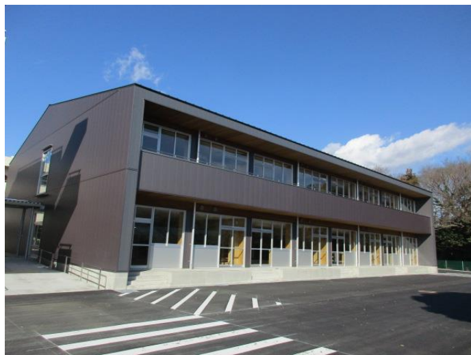
増築校舎外観
