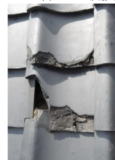
瓦が著しく破損している例
