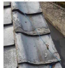
瓦が著しく破損している例
