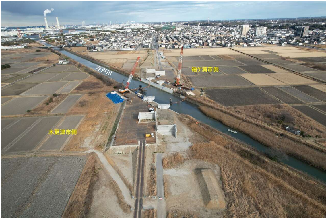
木更津市側から見た工事の様子
