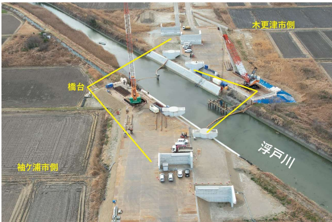
袖ヶ浦市側から見た工事の様子（拡大）
