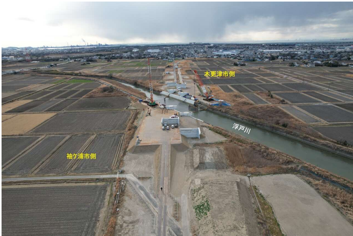
袖ヶ浦市側から見た工事の様子
