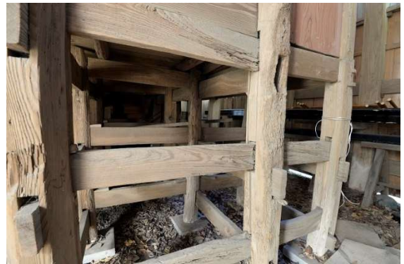
本殿下部の柱（北東から）
