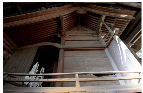
本殿東側面と屋根
