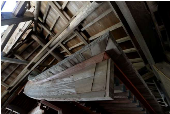
本殿屋根（南西から）
