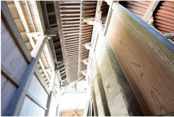
本殿背面と屋根（西から）
