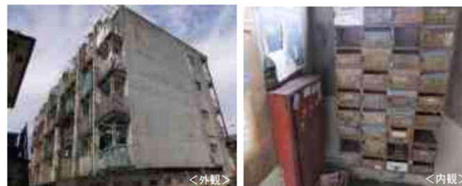
建物の傷みが著しく外壁の剥落、鉄骨の露出などが見られる事例
