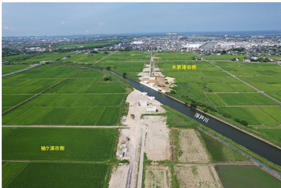
袖ヶ浦市側から見た工事の様子
