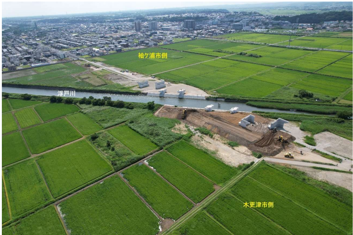
木更津市側から見た工事の様子
