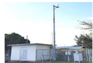
写真 大気環境常時監視測定局
