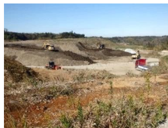
写真 建設発生土の埋立て事業場
