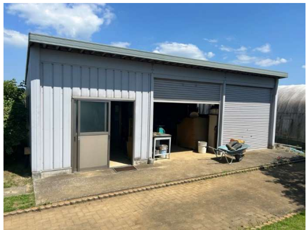
④ 倉庫外観 正面
