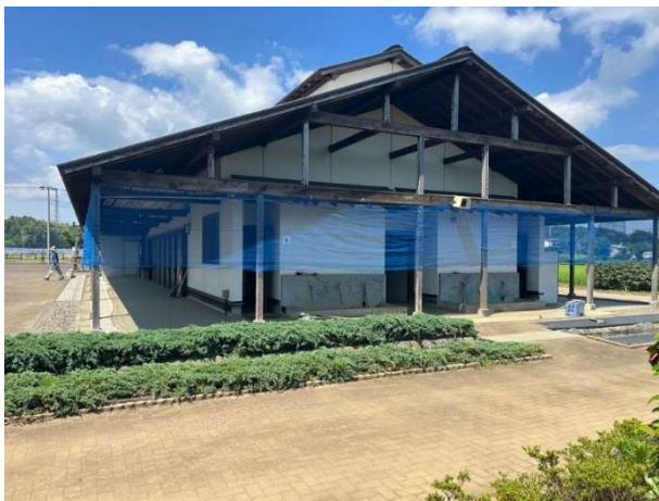
③ 管理棟外観 南側（手洗い場）
