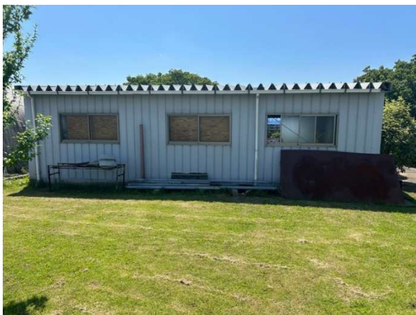
⑤ 倉庫外観 裏
