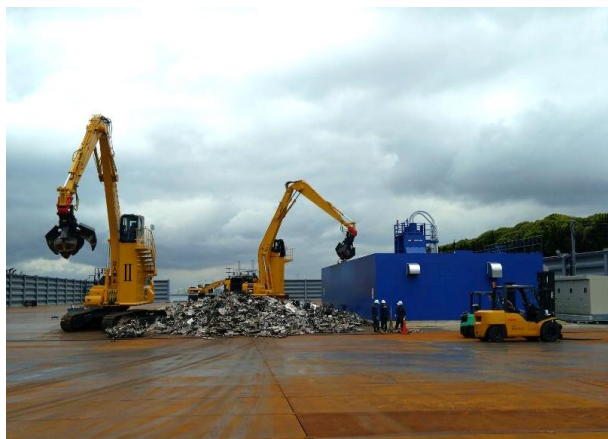
写真 屋外保管場の様子 (JSP 袖ヶ浦 RC ヤード)
