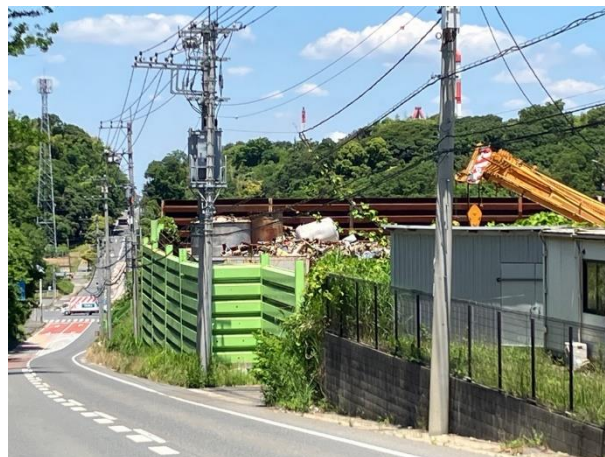
写真 屋外保管場の様子(外観)
