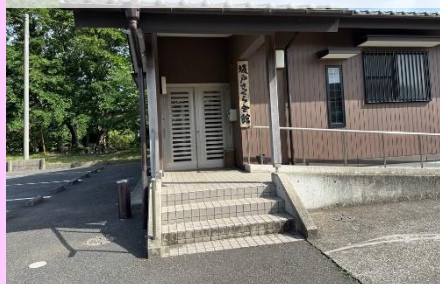
246_坂戸さくら会館
