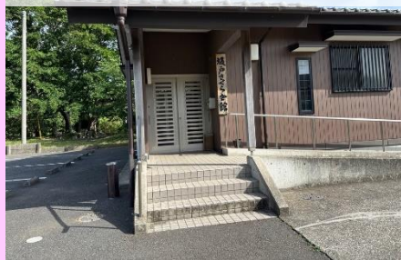
246_坂戸さくら会館
