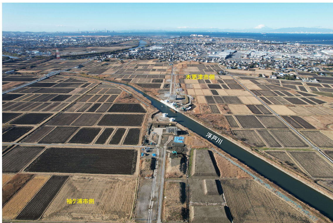
袖ヶ浦市側から見た工事の様子
