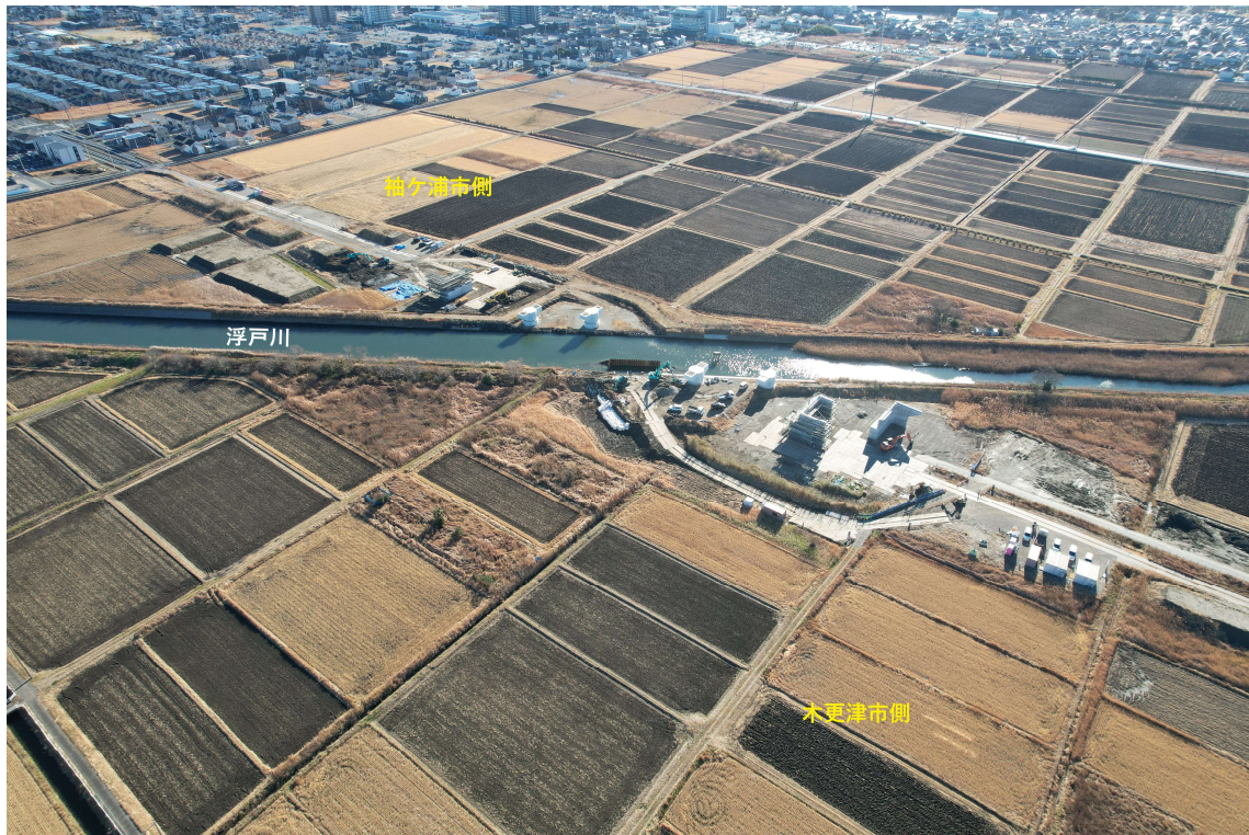
木更津市側から見た工事の様子
