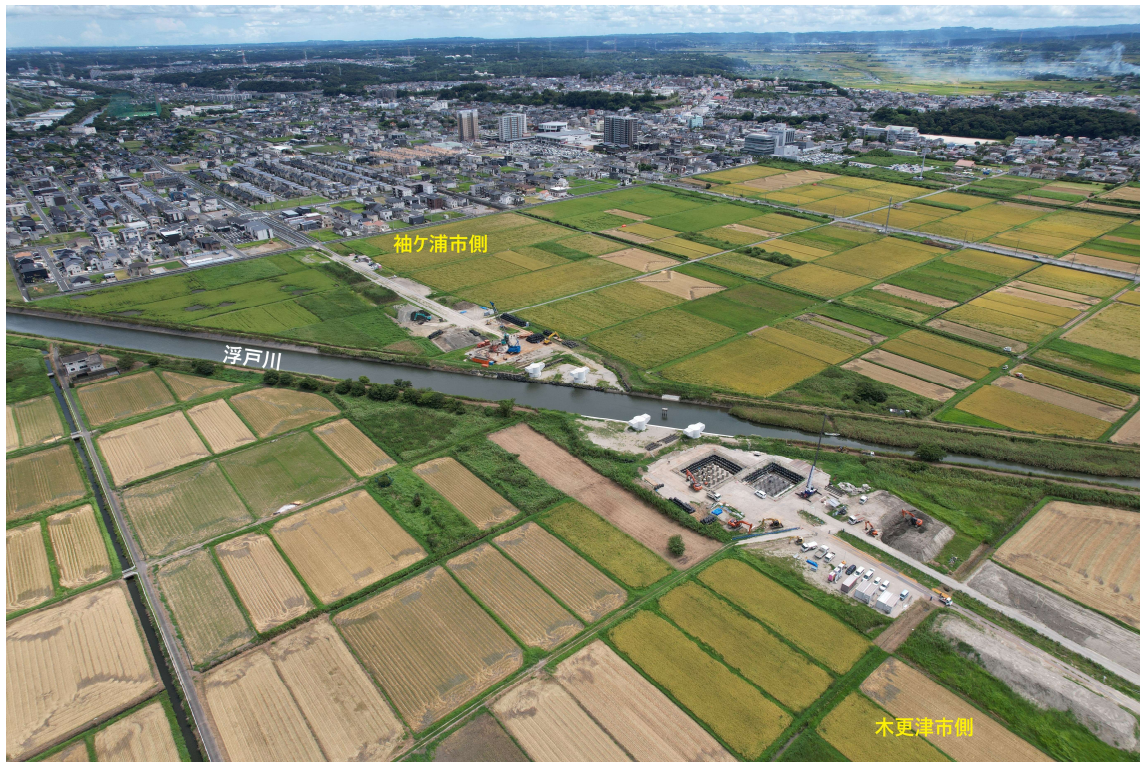
木更津市側から見た工事の様子
