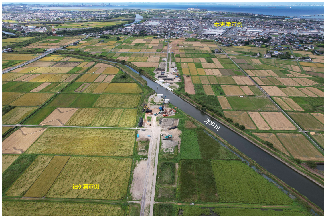
袖ヶ浦市側から見た工事の様子
