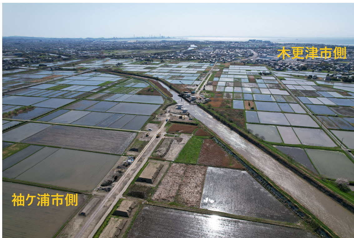
袖ヶ浦市側から見た工事の様子
