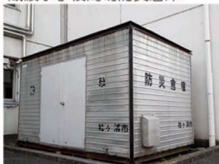
蔵波小学校簡易防災倉庫
