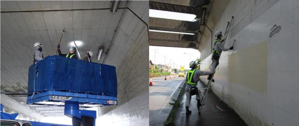
図2. 高所作業車及び梯子による定期点検の様子
