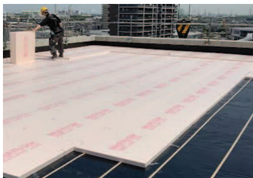
厚さ100mmの断熱材を使用した 屋根の高断熱化（北庁舎）
