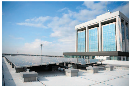
太陽光発電設備 （南庁舎）
