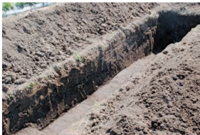
2. 27 T完掘（北西→）
