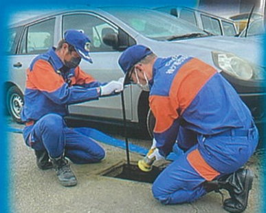
←火災発生時に使用する 水利（消火栓）の点検
