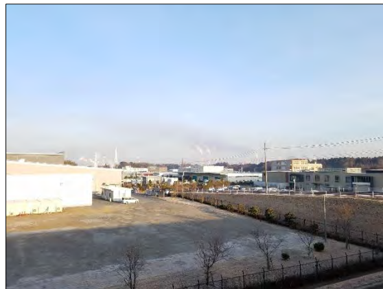
内陸部（椎の森工業団地）の工業地
