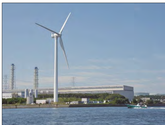
中袖地区の工場群
