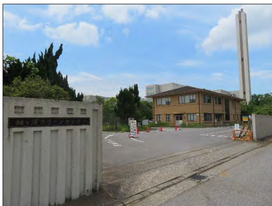
袖ヶ浦クリーンセンター
