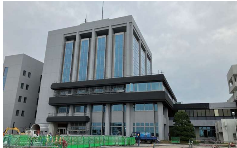
耐震改修をした中庁舎
