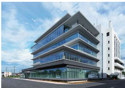
免震構造を採用した北庁舎
