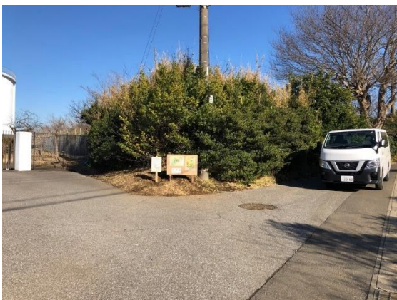
仮設駐車場案内板設置状況
