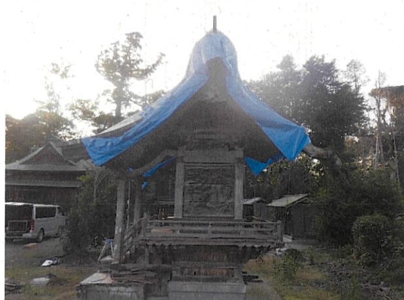
修理前 東側面全景
