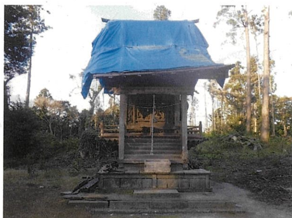
修理前 正面全景
