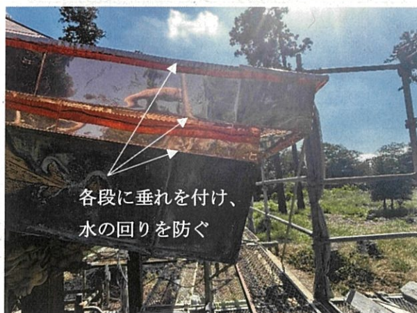
【写真7】修理後の軒付
