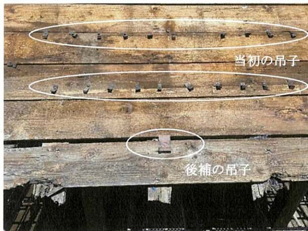
【写真1】野地板に残る吊子
