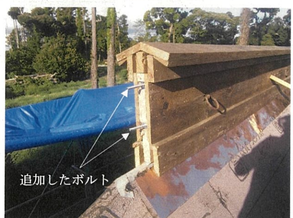
【写真8】鬼板を取付けるボルト
