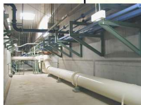
管廊 (水処理反応槽下部)
