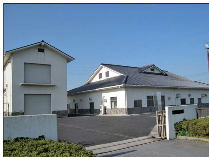
袖ヶ浦東部浄化センター
