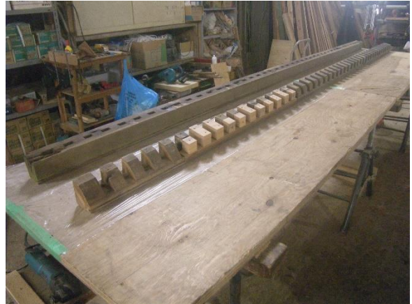
⑤ 木負 補修状況
