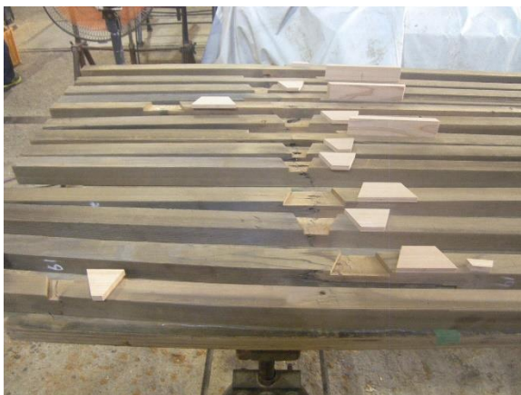
③ 地垂木 矧ぎ木状況
