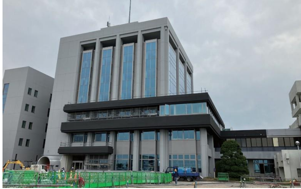
耐震改修をした中庁舎
