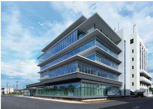
免震構造を採用した北庁舎
