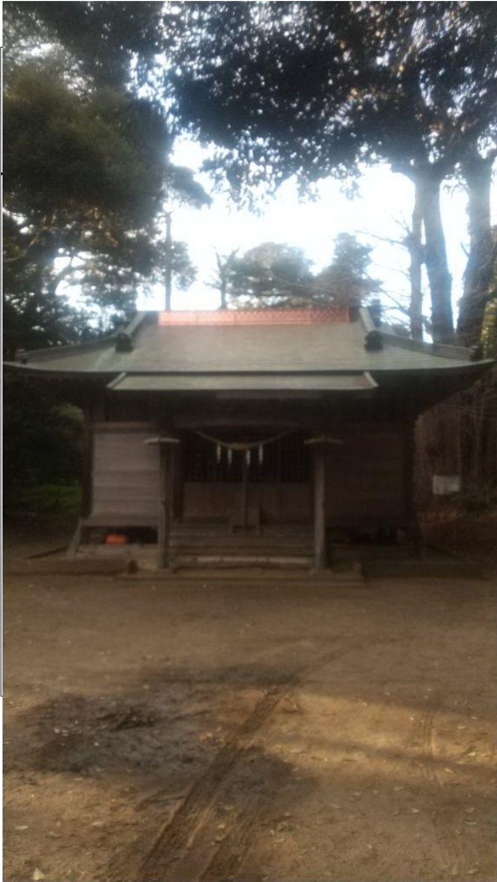
小高神社拝殿正面（棟の部分修復）
