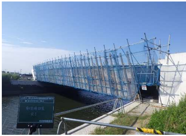
⑨吊足場・朝顔組立
