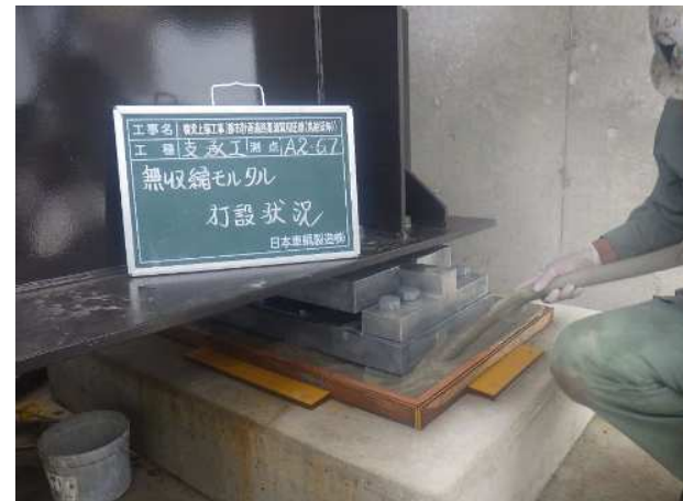
⑪支承モルタル打設
