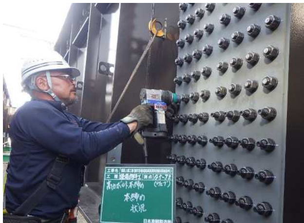
⑤主桁ボルト締付
