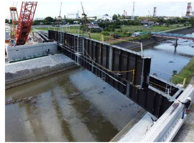
⑦主桁架設
