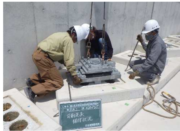
⑥支承仮据付
