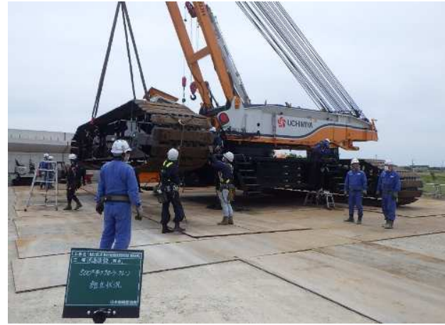
②クレーン組立
