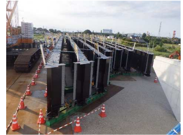
④主桁地組
