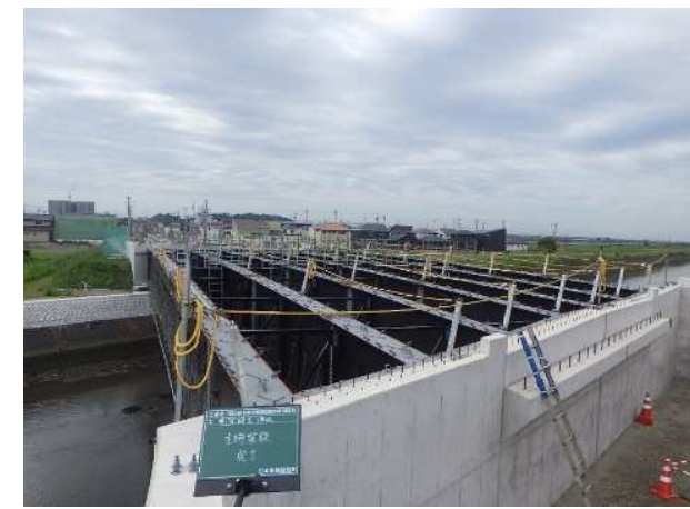
⑧架設完了
