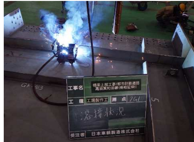
⑦補剛材溶接
