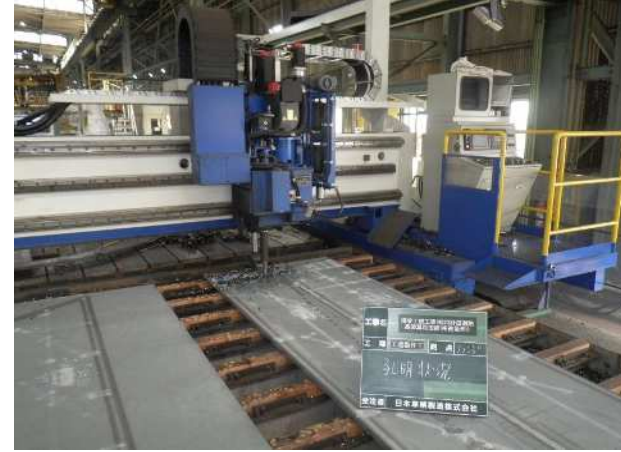
③ボルト孔明け
