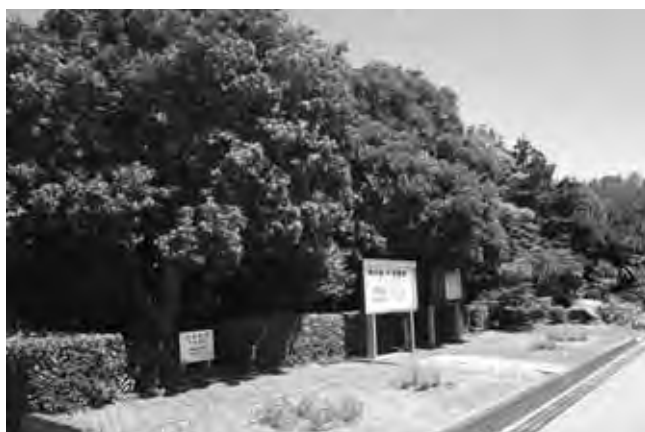
吉野石膏千葉第二工場
