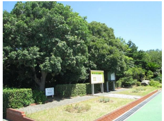
吉野石膏千葉第二工場
