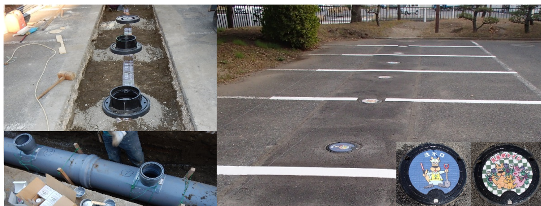
マンホールトイレの仕組み
