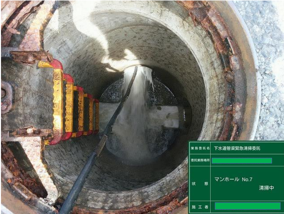
ホースが管の入口付近にある状態
