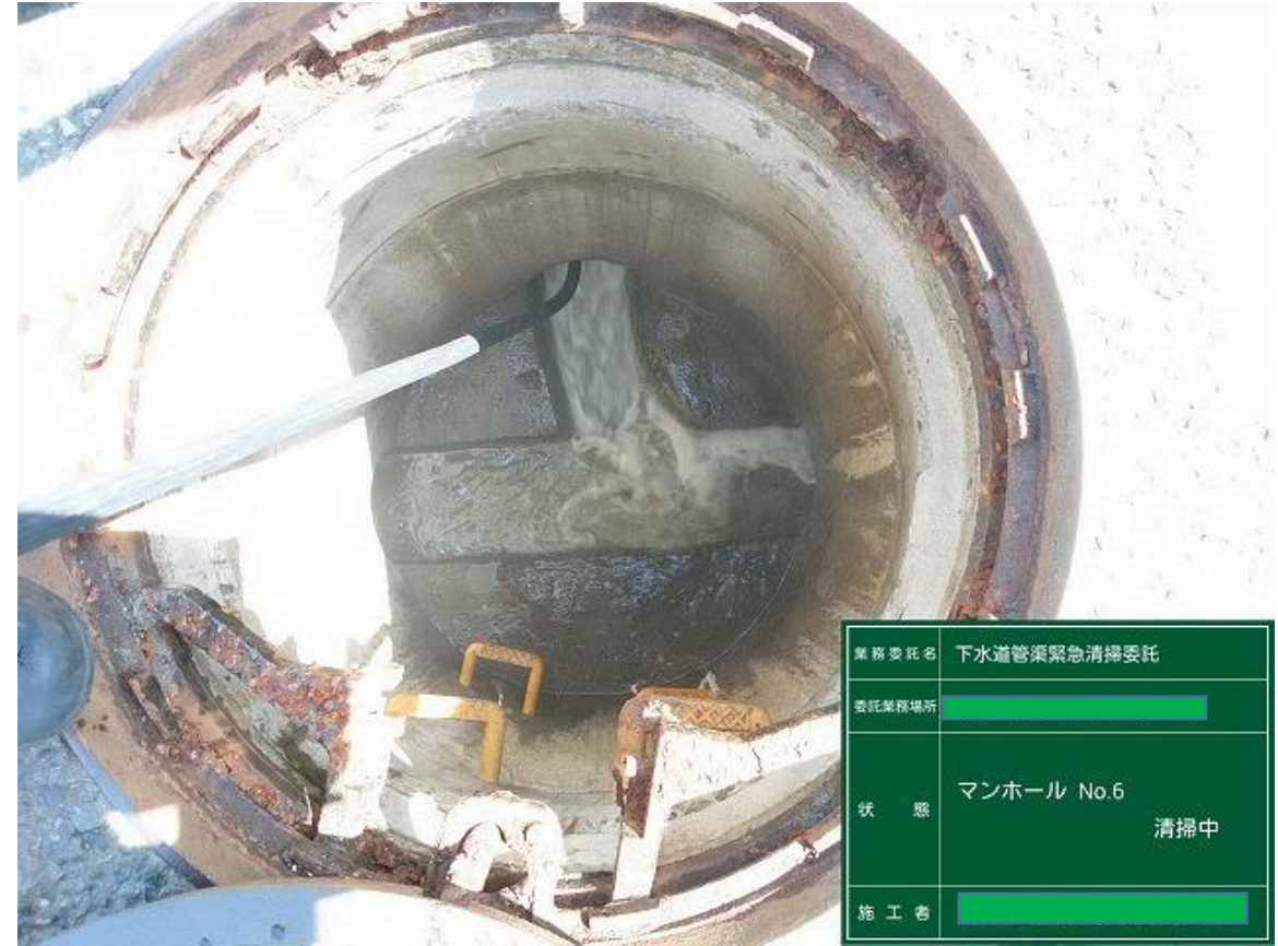
ホースが管の奥に進んだ状態
