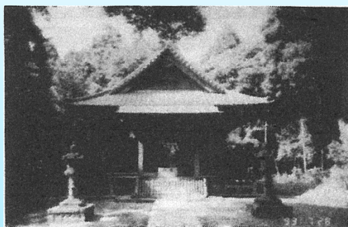
■外殿正面外観
